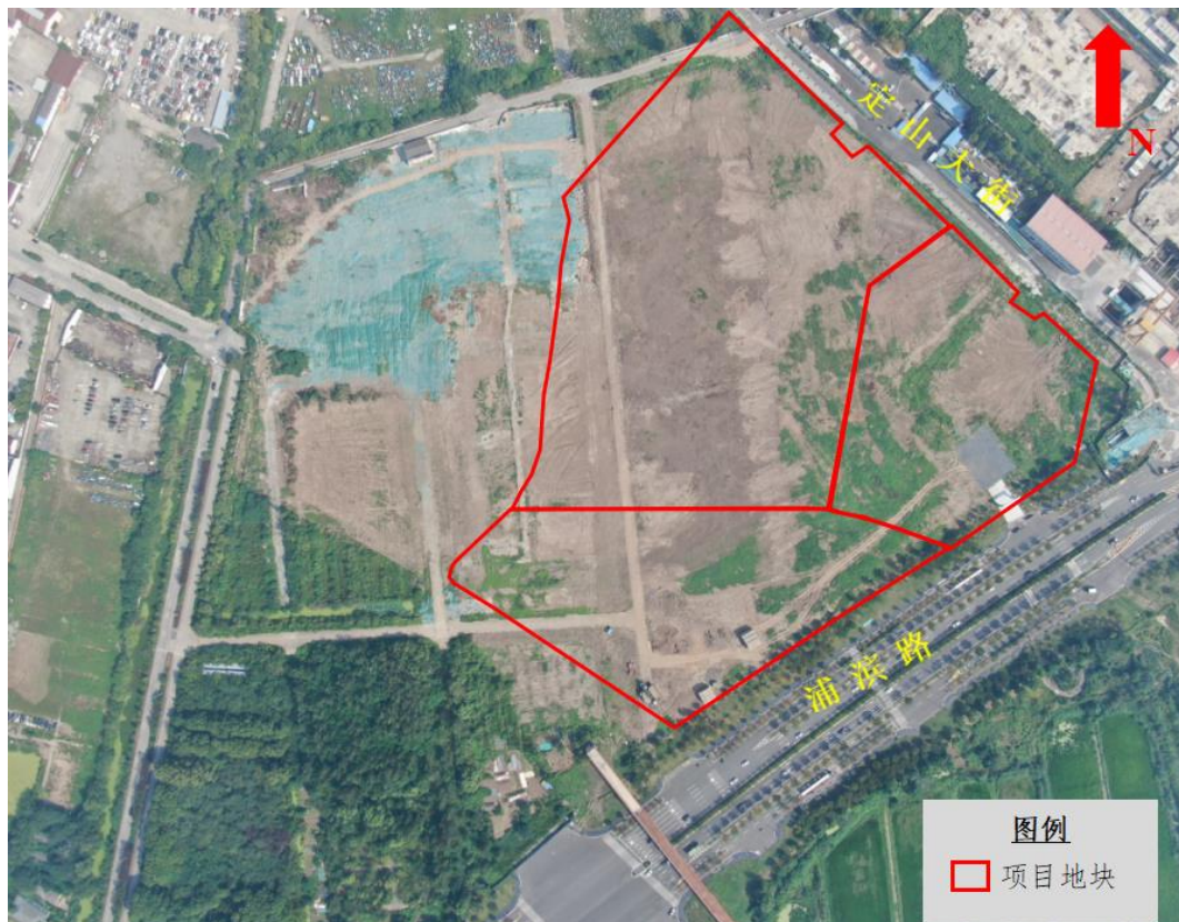
图 1.3-3 项目区现场航拍图（2025 年 9 月）
