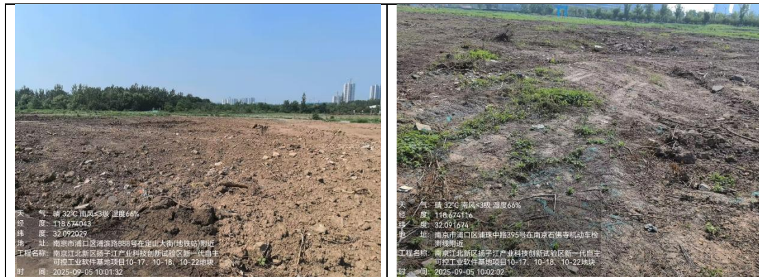
图 1.3-2 项目区现场情况（2025 年 9 月）
