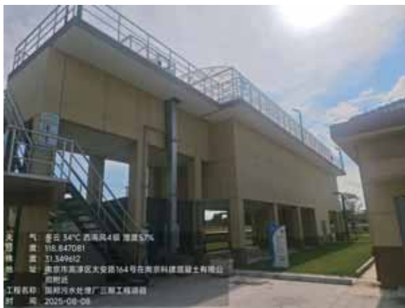
细格栅及曝气沉砂池
